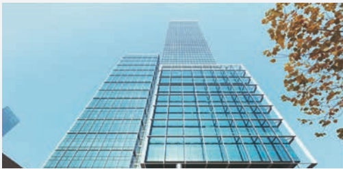
Многоэтажное здание без стилобата
